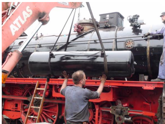
Anbau des Luftpessels
